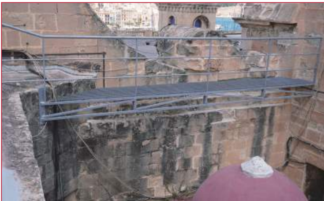
Wiehed mill-passaġġi tal-hadid, flimkien ma' railing protettiv li saru fuq il-bejt tal-knisja
